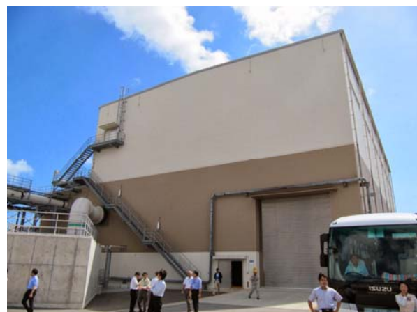
吉の浦火力2号機建屋の見学の様子
