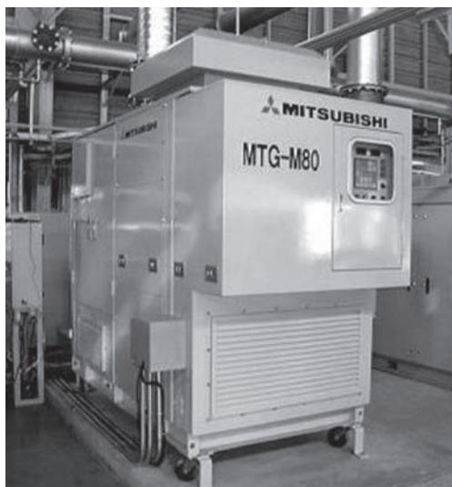
図7 再生サイクルマイクロガスタービン
