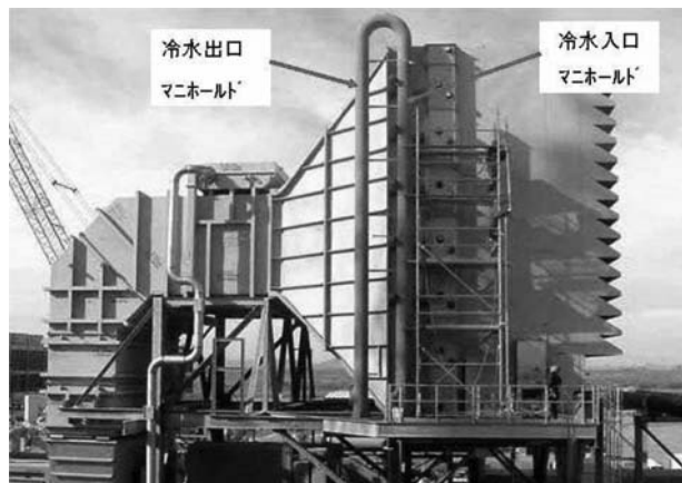
図13 ヘアピン型冷水マニホールドの実施例
