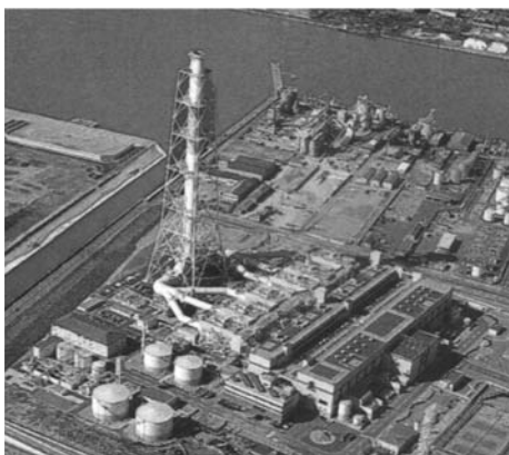
写真2 プラント全景
