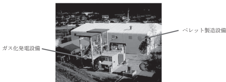
図7 実証試験設備 全景
