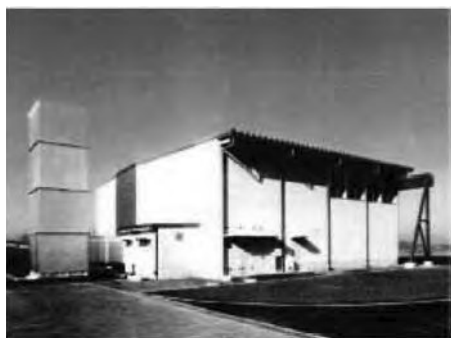
(b)消音ハンガー型式 (側面吸気: T4向け)
