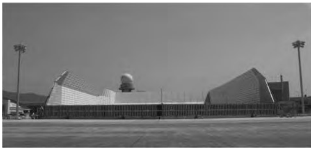
図7 大型防音壁全景
