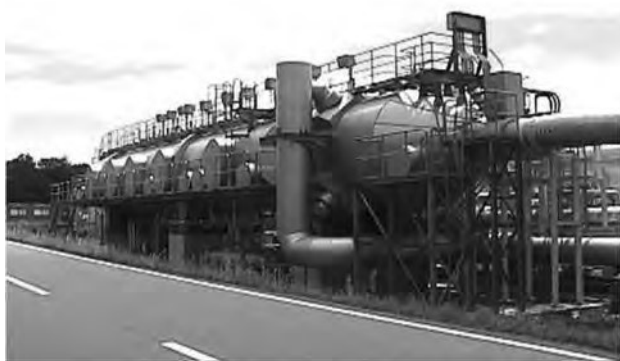
図6 給気冷却器(1)
