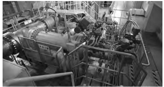
図8 高温配管予熱装置
