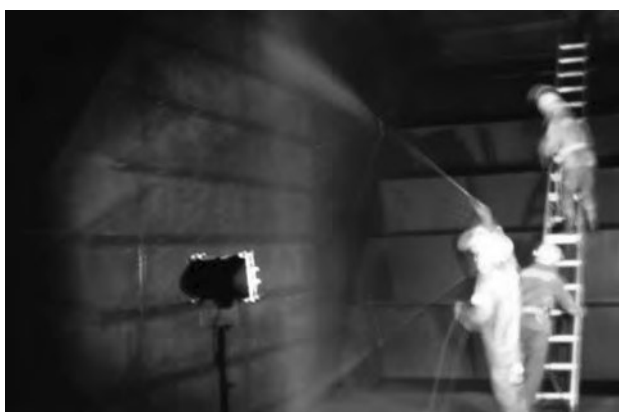
図22 洗浄作業の状況
