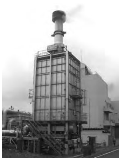
図7 給気加熱器
