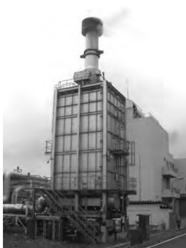
図7 給気加熱器
