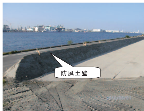
図9 風圧軽減のための防風土壁
