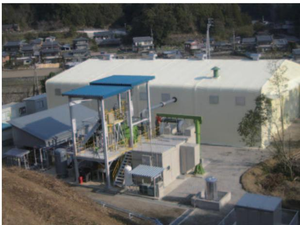
図10 木質バイオマスガス化発電システム（手前）およびペレット製造設備（奥）
