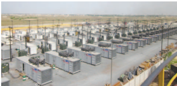
写真1 コンテナタイプDGを用いた100MW発電所
