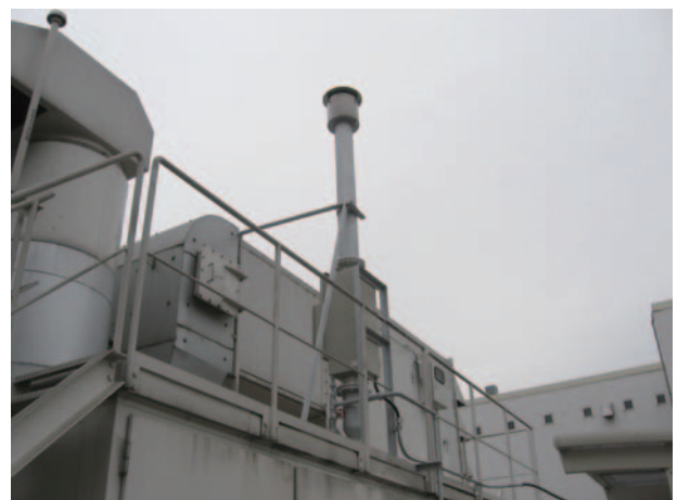
図3 電気式ミスト集塵機
