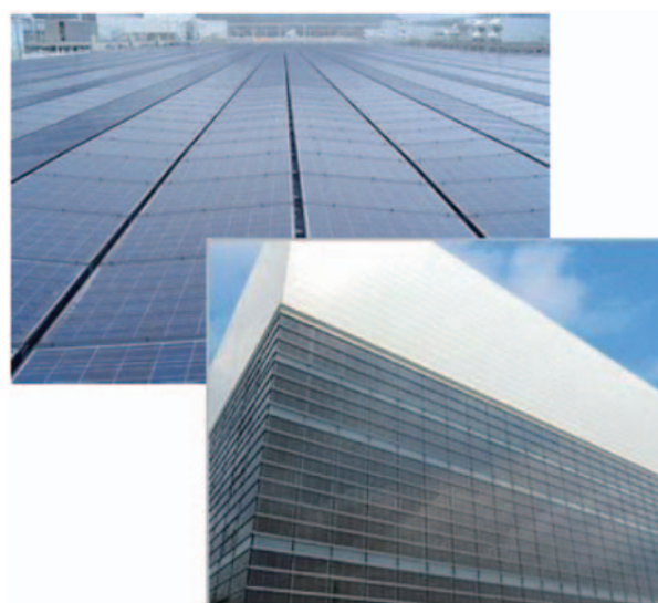
図3 太陽光発電システム
