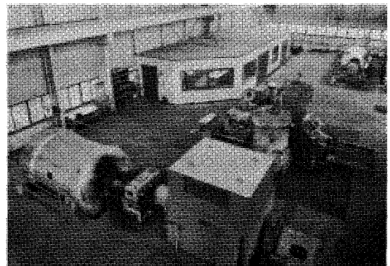
写真2 試験用高温ガスタービン設備
