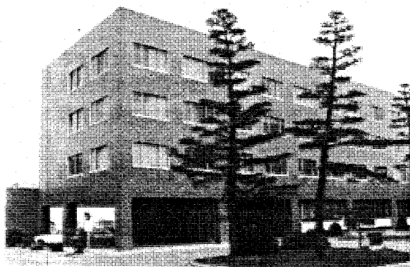
写真1 高速力学研究所1号館
