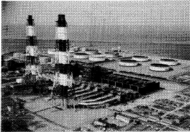
写真1 第3号系列全景
