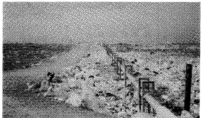
ガス田30ha（昭和40年代後半から厨芥を主とする可燃ごみを埋立てである。）から出るガスのおよそ5分の1を回収していることになるという。20000 N<sup>m</sup>のうち発電には12000 N<sup>m</sup>用い、8000 N<sup>m</sup>は前処理施設に利用する。またガス田の寿命は約20年と見ている。主要設備としてはガス抜き管、各ガス抜き管を集合する誘導管（250 A）、ミストセパレータ、ガス誘引のためのルーツプロア、ガス冷却設備、ガスホルダー（500 m<sup>3</sup>）があり、さらにガス中の酸素濃度が増加した場合に緊急遮断装置が作動することとなっている。
