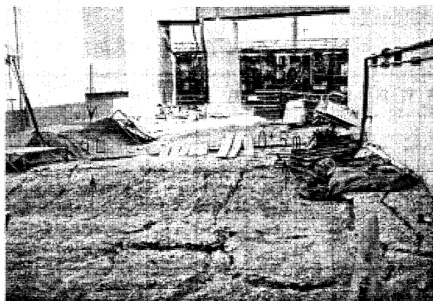
図6 配管ピット陥没
