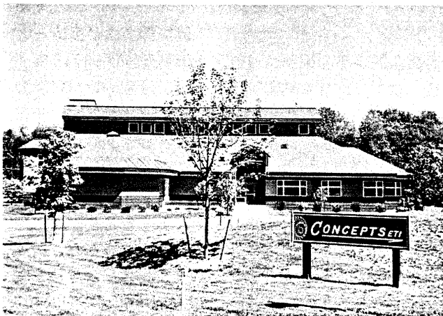
写真1 コンセプト ETI 社 本社全景
