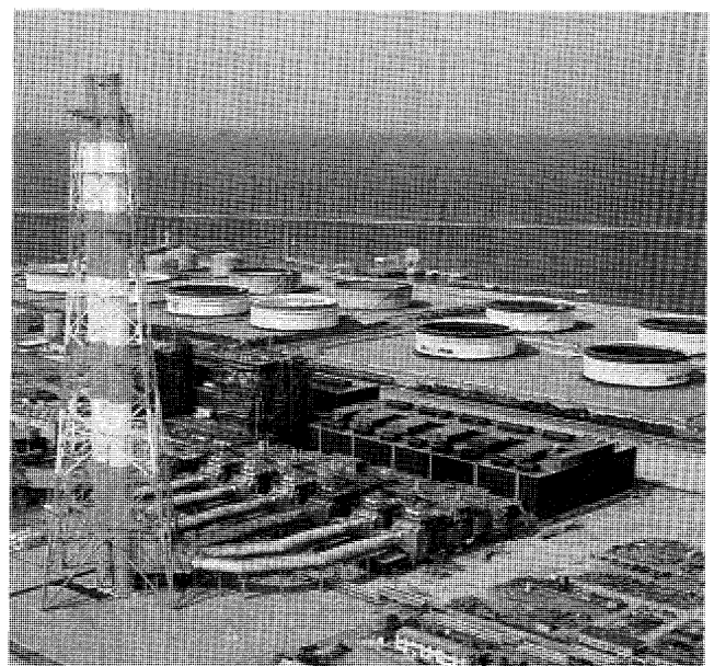
図10 東北電力東新潟火力発電所1090MWコンバインドサイクルプラント
