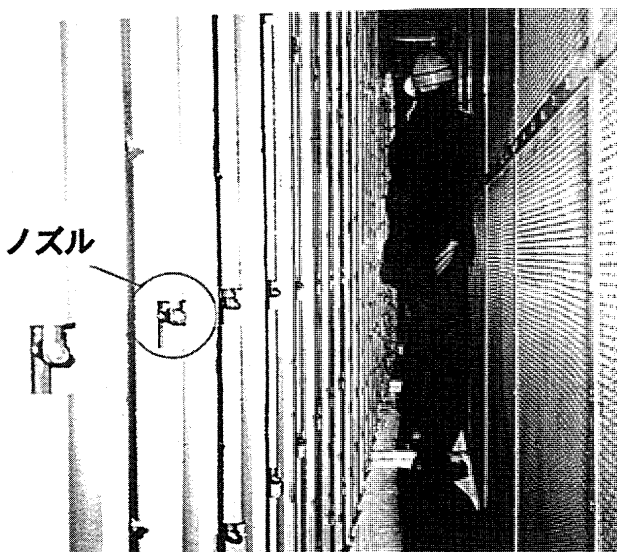
図4 噴霧ノズルラックの設置状況
