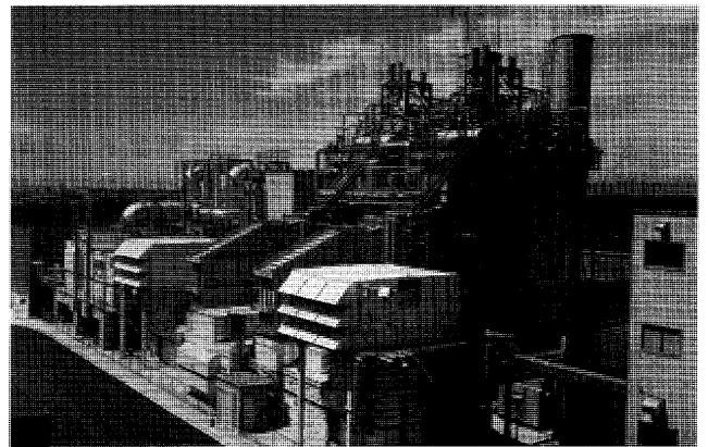
図1 藤沢工場第二発電所
