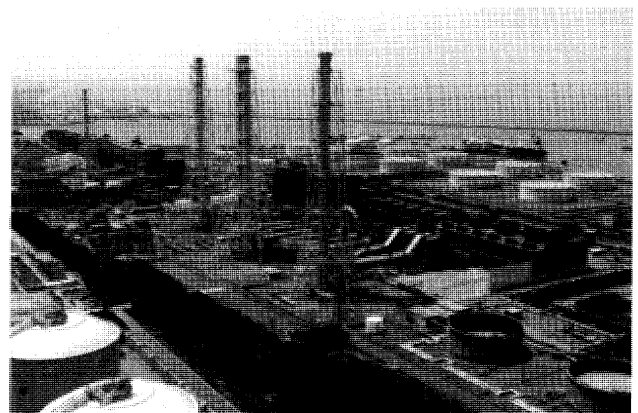
図2 東新潟火力発電所全景
