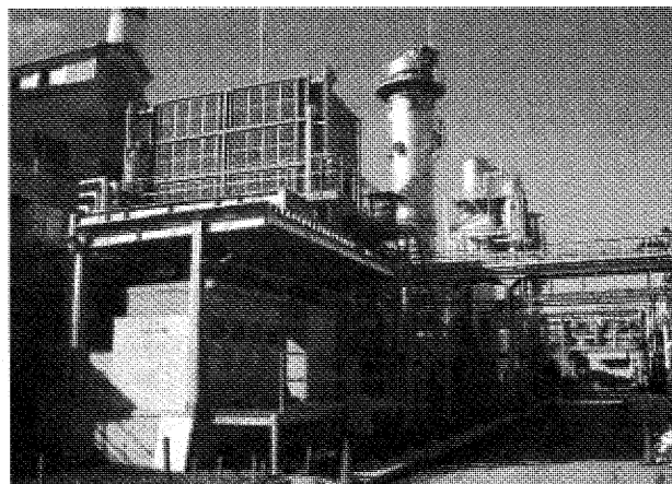
図11 バイパススタックおよび排気スタック (ガスタービン前側より見る)
