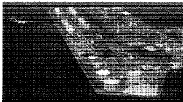
大阪ガス(株)泉北製造所第二工場全景
