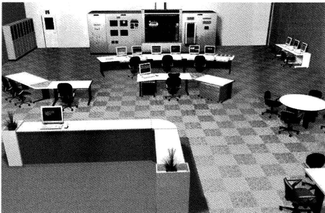
図7 250MW級IGCC実証機中央制御室
