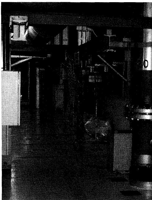
写真2 通路に下がっている鉤付きチェーン
