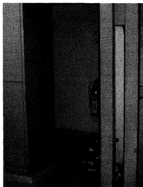
写真4 消火器が柱や装置の影に隠れてほとんど見えない
