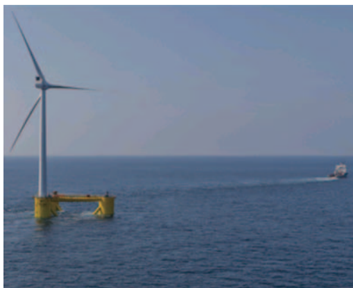
図4 WindFloat (5) 浮体式洋上風車
