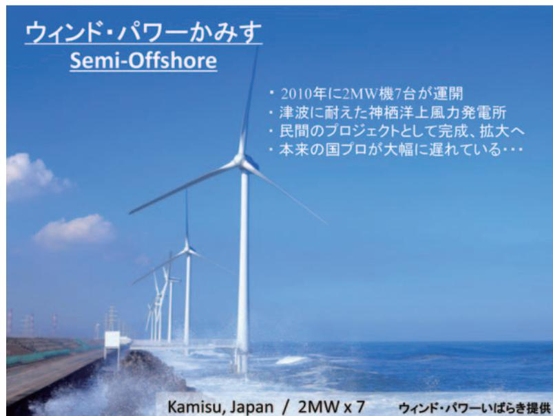
図9 津波に耐えた洋上風車 (神栖, ウィンドパワーいばらき提供)
