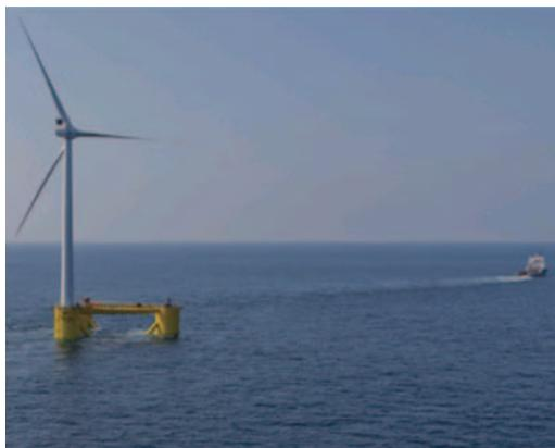
図4 WindFloat<sup>(5)</sup>浮体式洋上風車
