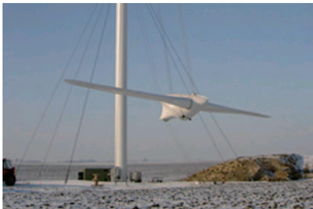
図6 Vergnet GEV HP-1MW施工状況 11)
