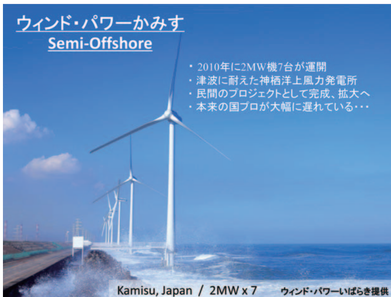
図9 津波に耐えた洋上風車 (神栖, ウィンドパワーいばらき提供)
