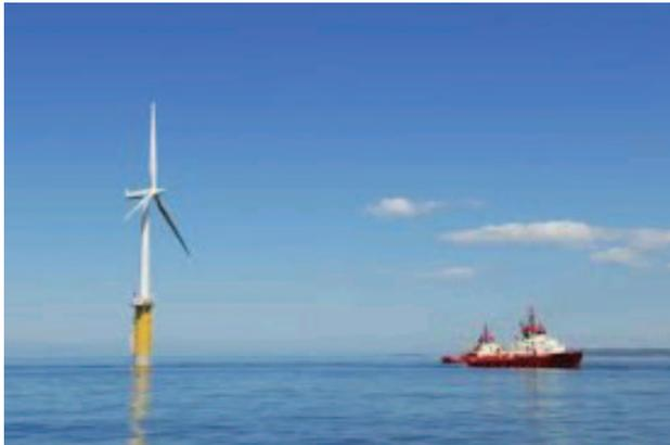
図3 Hywind<sup>(4)</sup>浮体式洋上風車
