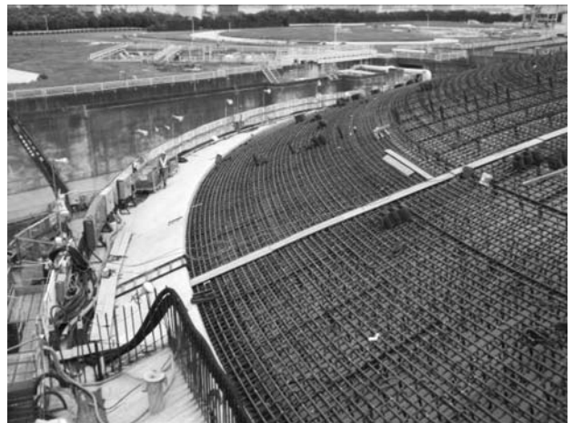
写真1 地下タンク（屋根上の足場からの外観）
