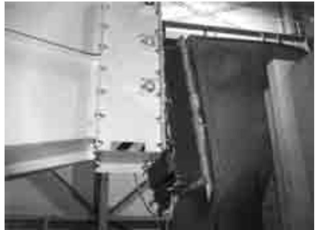
図4 常用ガスタービンの被害 ファン移動によるキャンパス継手の損傷(資料提供:日立造船株)
