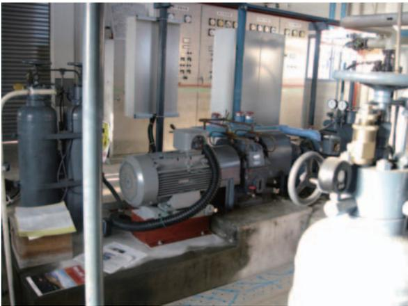
復旧状況（エンジ基礎上に電動機を据付）
