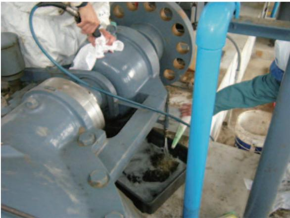
主ポンプ外軸受内部の砂除去作業
