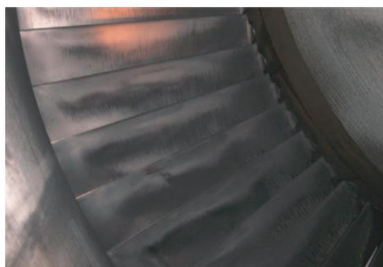
Fig. 7 HEPAフィルタ設置前翼状況
