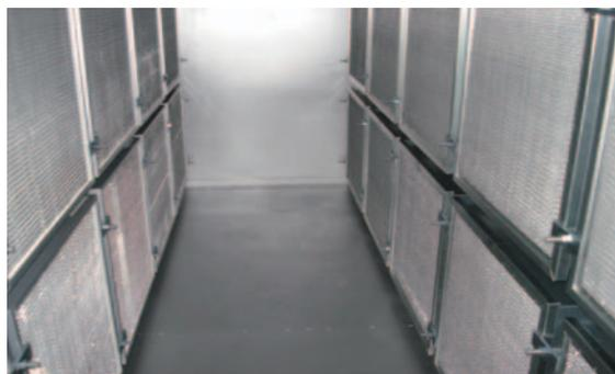
Fig.3 二次，三次吸気フィルタ取付例
