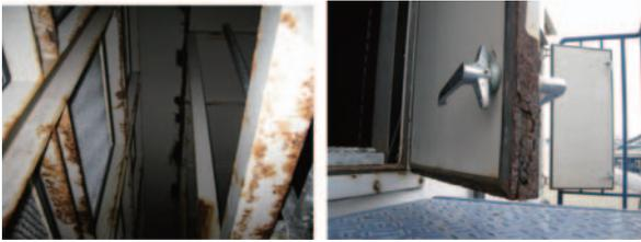
Fig.24 ダクトなどの錆事例(左:フィルタ枠の錆, 右:フィルタ室扉錆腐食)
