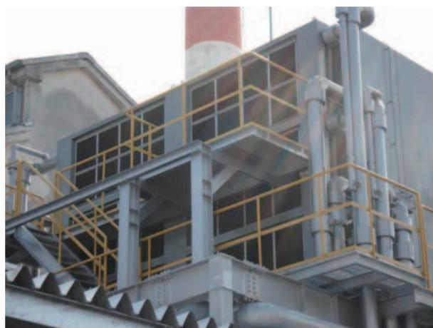
Fig.19 ガスタービン空気取入室前面の冷却器外観
