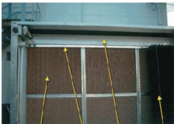
Fig. 6 気化式吸気冷却器（下流側より見る）
