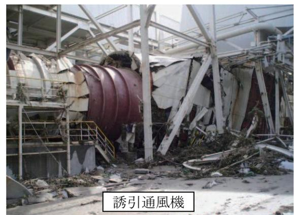
Fig. 7 原町火力発電所の被害状況
