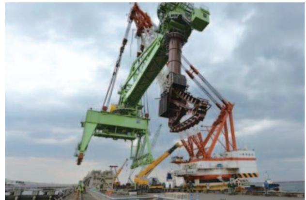
Fig.10 原町火力発電所復旧状況 (揚炭機水切り)
