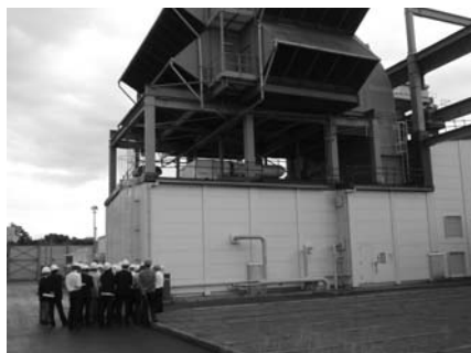
写真1 (株)東京ガス横須賀パワーステーション
