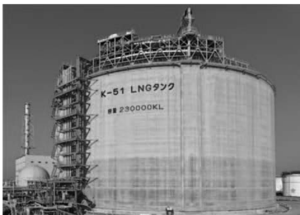
Fig. 15 Overview of 230,000m 3 PC LNG tank in Senboku LNG Terminal 1, Osaka Gas
