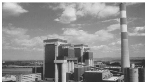
Fig. 2 完成したDuernrohr発電所 (写真提供：EVN)
