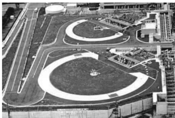
Fig. 6 Underground LNG tank (3)
