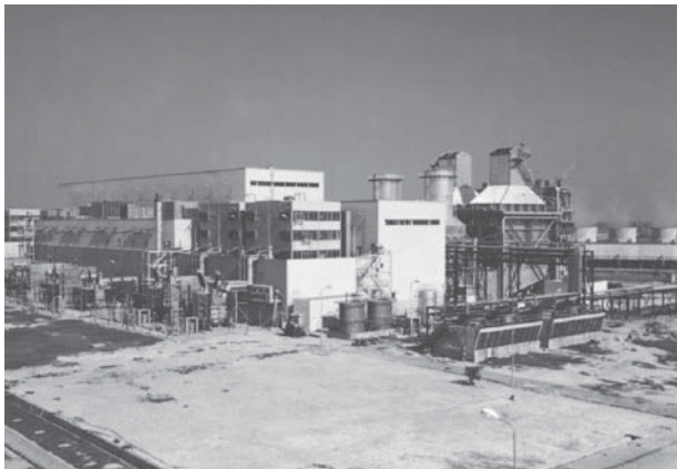
Fig. 8 発電所の全景写真 (自ら鉄塔によじ登って撮った思い出の写真)
