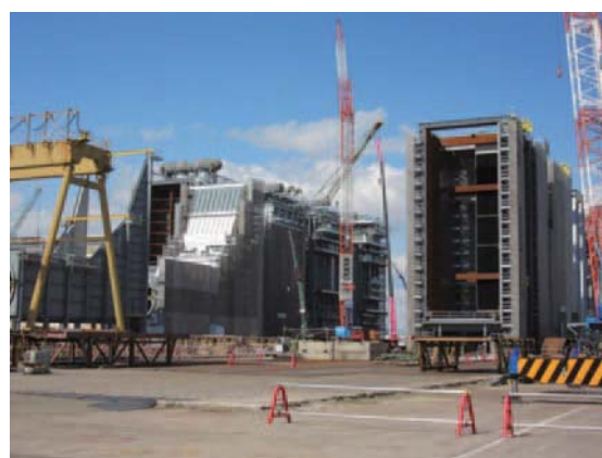
Fig. 5 HRSG Super Module Assembly Site
