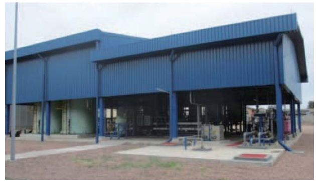
Fig. 9 追設した水処理設備
