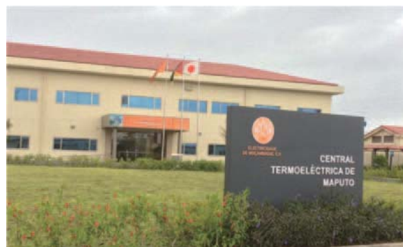
Fig. 11 プラント管理棟
