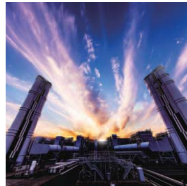
図4.2 JERA川崎火力発電所
