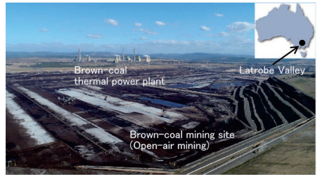
Fig. 2 Loy Yang coalfield in Latrobe Valley, Australia
