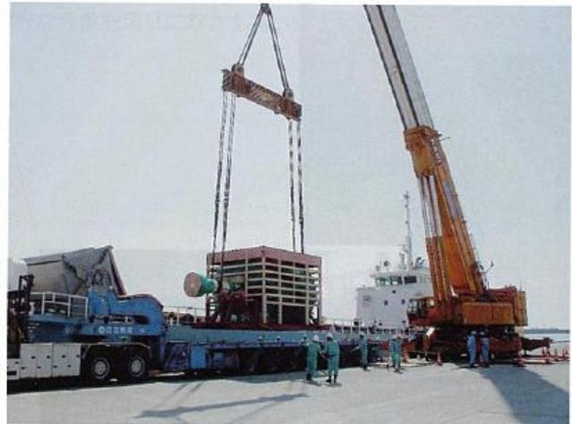
蒸気タービン低圧ロータ
