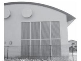
弊社はガスタービンコンバインドサイクルに於ける吸気フィルター用のアルミ製「ウェザールーパー」「遮音防水ルーバー」の製作を行っております。有効開口率が50%ありながら、台風時を上回る降水量と強風を用いた性能試験でも防水効率は99.9%。通気性にも優れたコストパフォーマンスの高い製品です。
