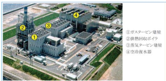
図 16 実証発電設備 (T 地点) 3)
