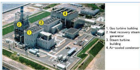
図 20 実証発電設備 (T 地点) 5)
