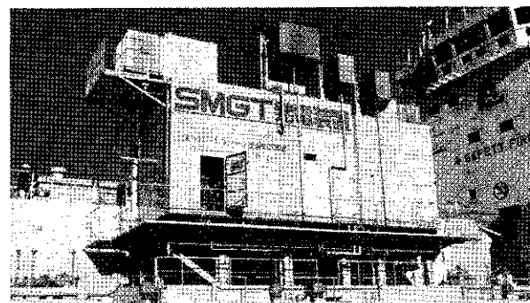
図7 SMGT 発電装置外観
