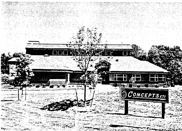
写真1 コンセプト ETI 社 本社全景
