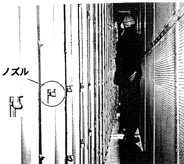
図4 噴霧ノズルラックの設置状況
